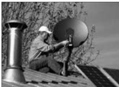
Ukázka případné montáže na střechu. Parabolu lze umístit také na zeď, balkon atd. Důležitý je výhled trošku nad jižní pól.
